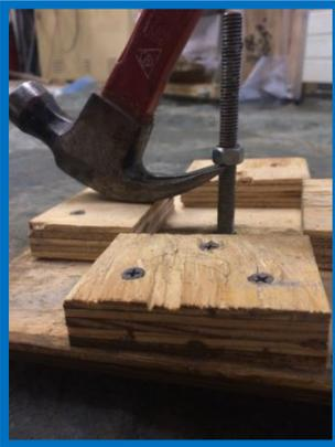
*Utilisez l'arrache-clou du marteau contre l'écrou. Lors de l'assemblage du moule, assurez-vous que l'écrou soit au milieu. NE LE SERREZ PAS.*
