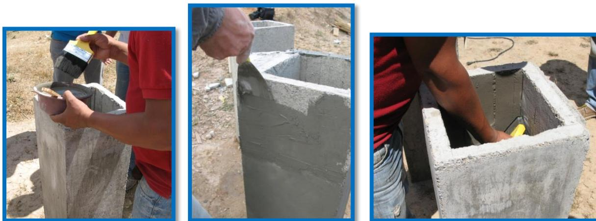
*Mélanger le ciment et l'eau et appliquer le mélange à l'intérieur et à l'extérieur du filtre pour boucher les trous.*
