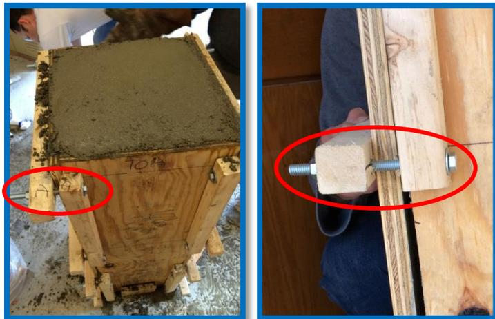
*Les boulons servent à faire tenir les parties extérieures du moule pendant le temps de séchage du béton.*
