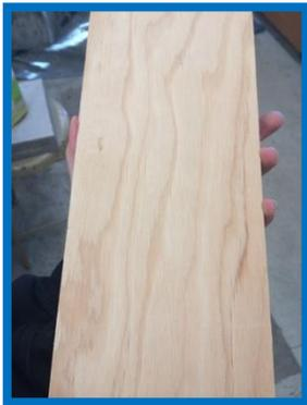
*Certificar que o lado liso da madeira compensada fique virado para o concreto.*
