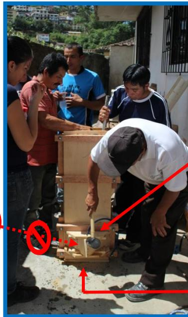
*NÃO bater diretamente nos lados do Bico (Peças U e V). Isso irá danificar o Bico.*
