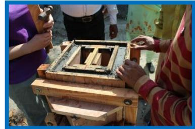
*Depois de virar o Molde para desmontagem, a Tábua Central estará virada para o topo, facilitando a remoção.*
