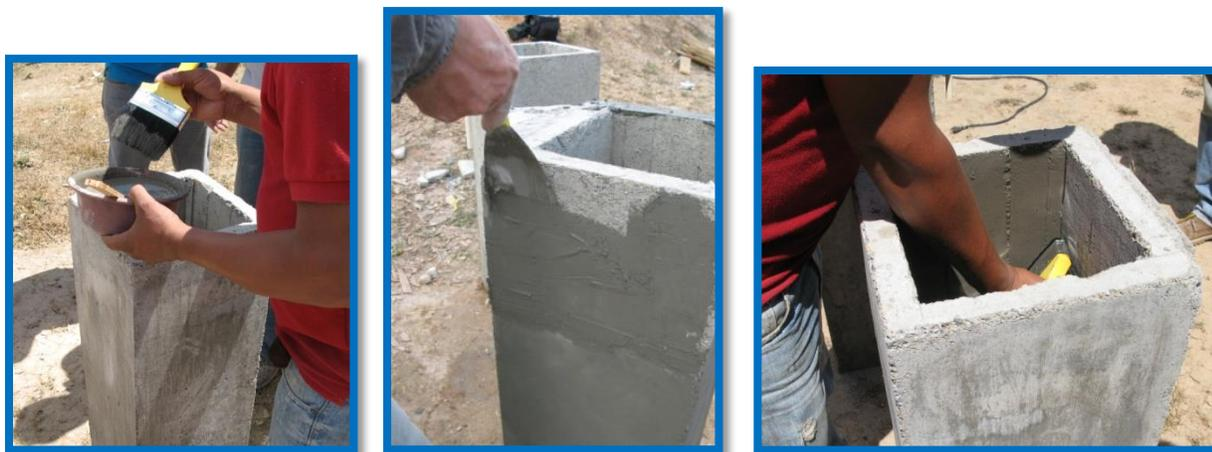
*Misturar o cimento e água e aplicar dentro e fora do filtro para selar quaisquer furos.*
