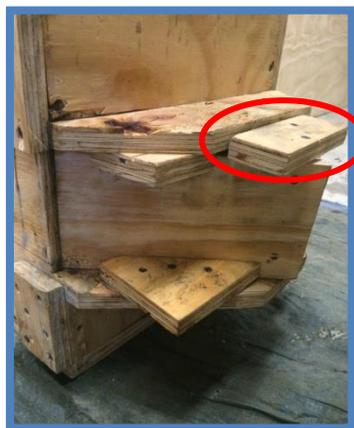
*Nas figuras a direita e a esquerda, a Peça UV é maior que a Peça T. Usar uma peça de madeira de sobra para cobrir o espaço (como mostrado). Você deve prender a madeira de sobra na Peça UV.*
